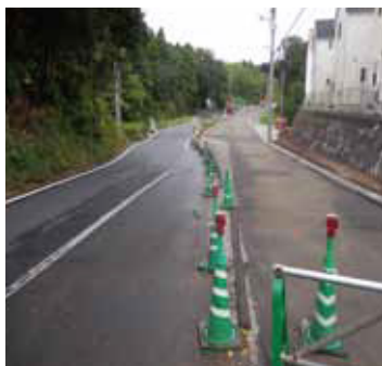
▲御成街道、側接続箇所
